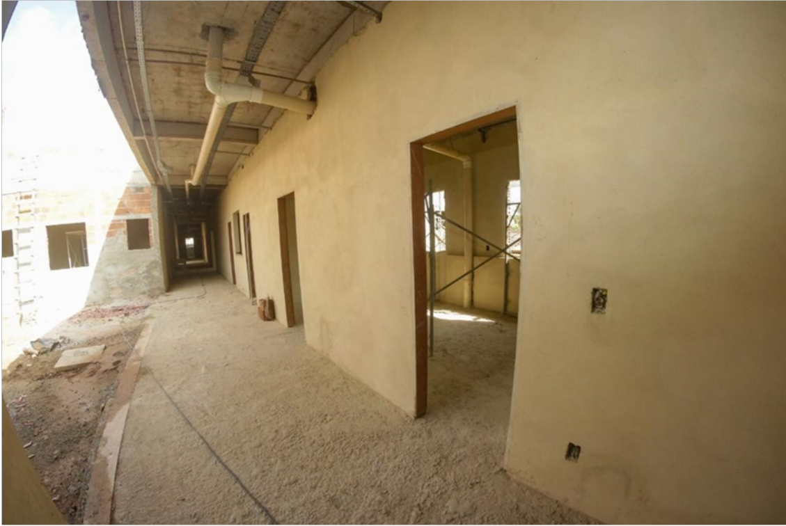
Fig.4 – Corredor ao lado do pátio interno. Imagem da obra.
