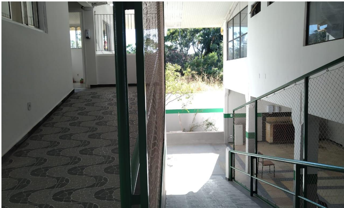
Figura 12 RAMPA DE ACESSO
