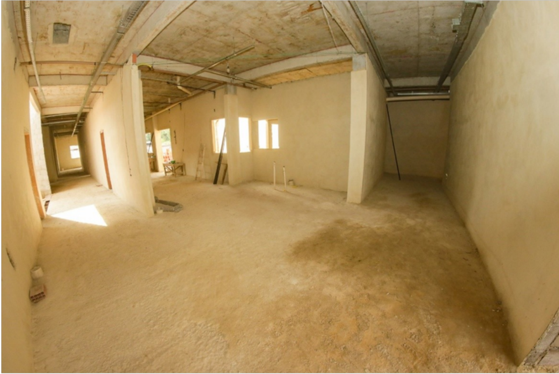
Fig.6 – Refeitório. Imagem da obra.
