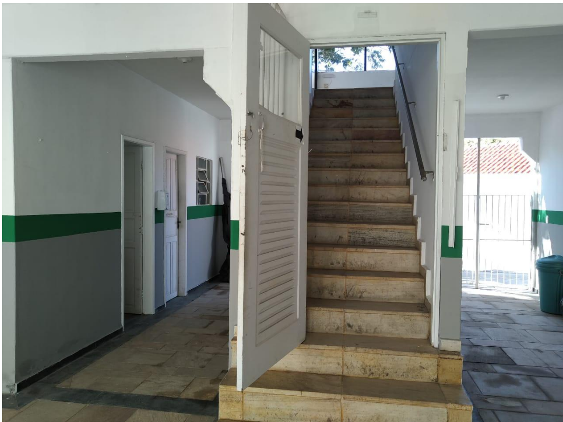
Figura 14 ESCADA PREDIO ANEXO
