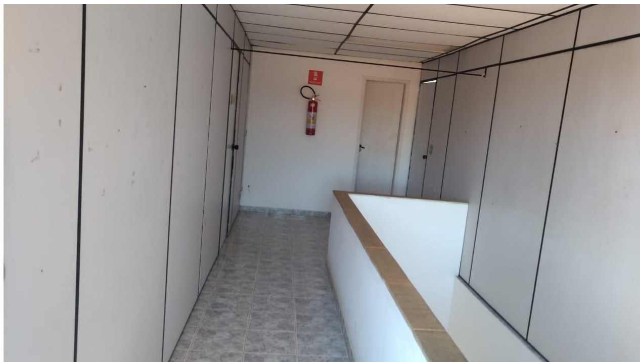
Figura 15 CORREDOR PREDIO ANEXO
