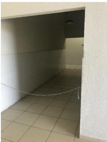
Figura 5. ENTRADA LATERAL ESQUERDA
